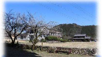
新棟建設予定地
